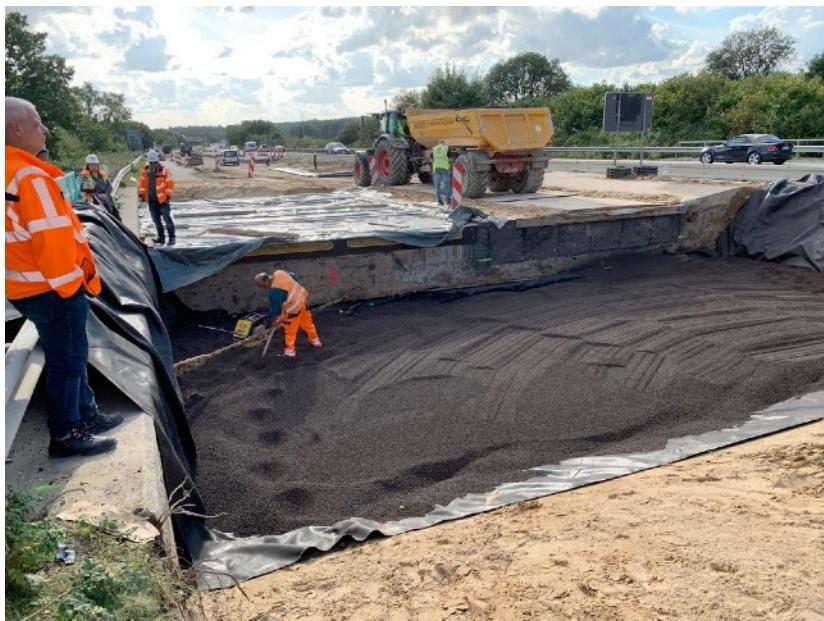
**Da Blähton leicht ist und viel Gewicht einspart, kommt er im Erd- und Grundbau häufig zum Einsatz. Auch die Autobahn GmbH des Bundes, Nord, nutzte für die Brückensanierung auf der A1 zwischen Pansdorf und Neustadt i.H. die federleichten Tonkuhlen. Sie ließ die Brückenwiderlager mit HansePor® hinterfüllen. Dadurch lastet weit weniger Gewicht auf den Widerlagern als üblich.**
