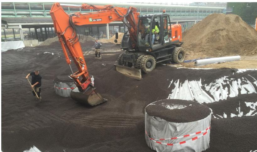
**Blähton ist leicht und spart im Vergleich zu herkömmlichen Baustoffen viel Gewicht ein. Dieser Vorteil wurde für die Überbauung des Energiekanals im Chempark Leverkusen genutzt: 460 Kubikmeter Blähton wurden im Mai auf dem Energiekanal verteilt. Dadurch lastet weit weniger Gewicht auf dem Kanal als üblicherweise.**
