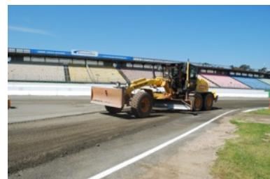
Die spezielle Wegedeckenmischung „HG-Mix®“ soll künftig für den Bau von Straßenbanketten eingesetzt werden.
