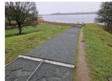
Zum Einsatz kam der Hanse-Grand Patentweg®, eine innovative Lösung, die ohne Eingriff ins Erdreich auskommt. Dabei wird ein spezielles Kantengeotextil auf dem geebneten Boden ausgebreitet und fixiert. Es bildet eine sichere Barriere zwischen altem Erdreich und neuem Belag, wandelt Punktlasten in Flächenlasten um und schützt auf diese Weise die empfindlichen Wurzeln von Bäumen und Pflanzen.
